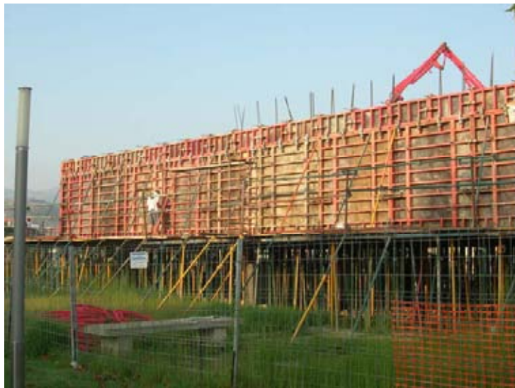
Hormigonado de la pieza
