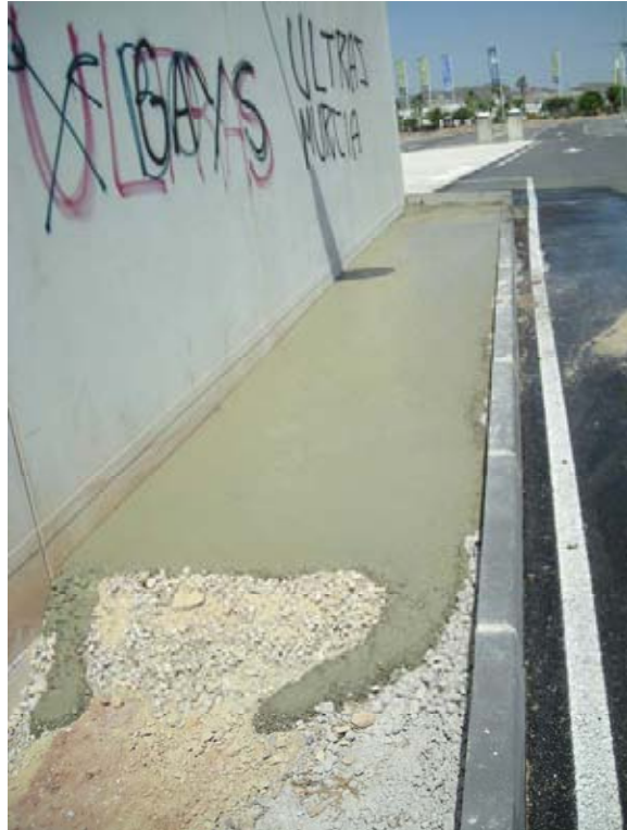
Avance del hormigón Autocompactante
