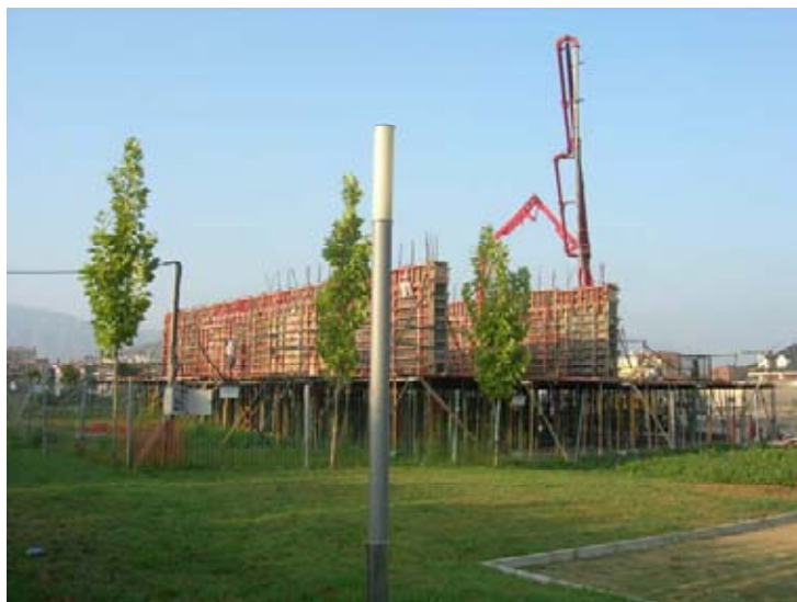
Vista General de la obra.
