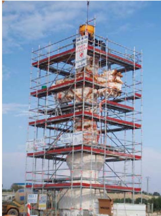
Hormigonado de la pieza.
