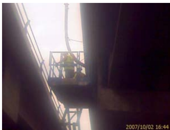
Hormigonado del cajón de hormigón del viaducto.
