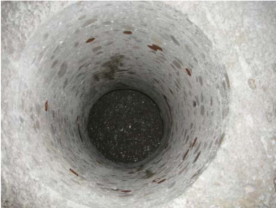
Paso de Hormigón bajo la losa
