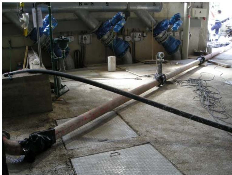
Tubería para el vertido de hormigón desde punto exterior.
