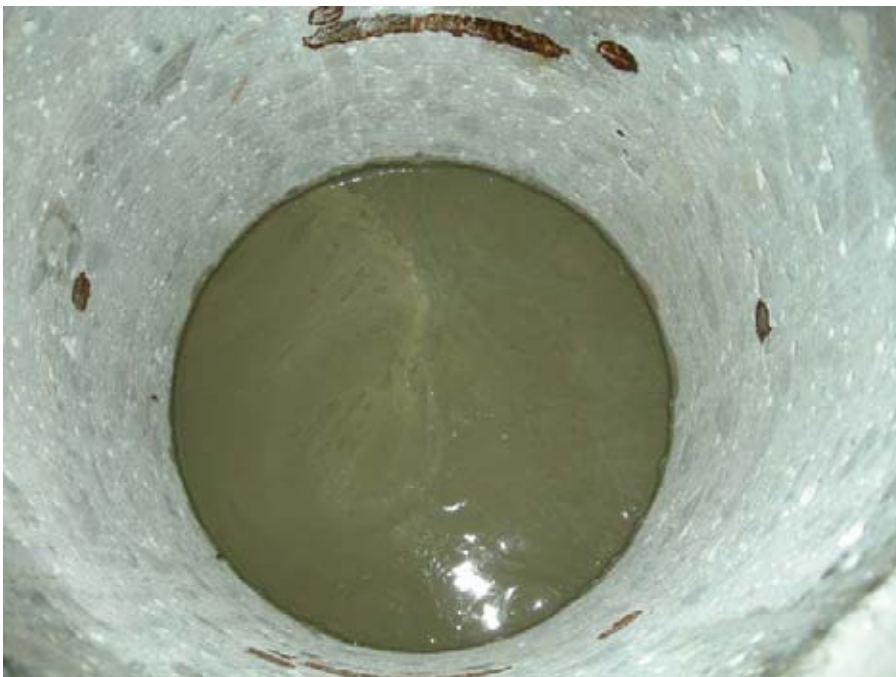
Ascensión del Hormigón en un agujero cercano a la zona de hormigonado.
