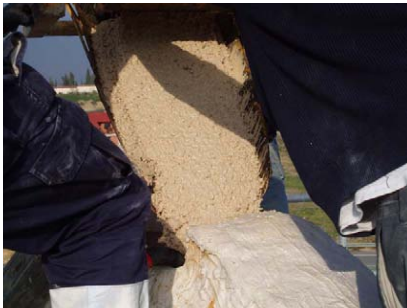
Detalle vertido de Hormigón.
