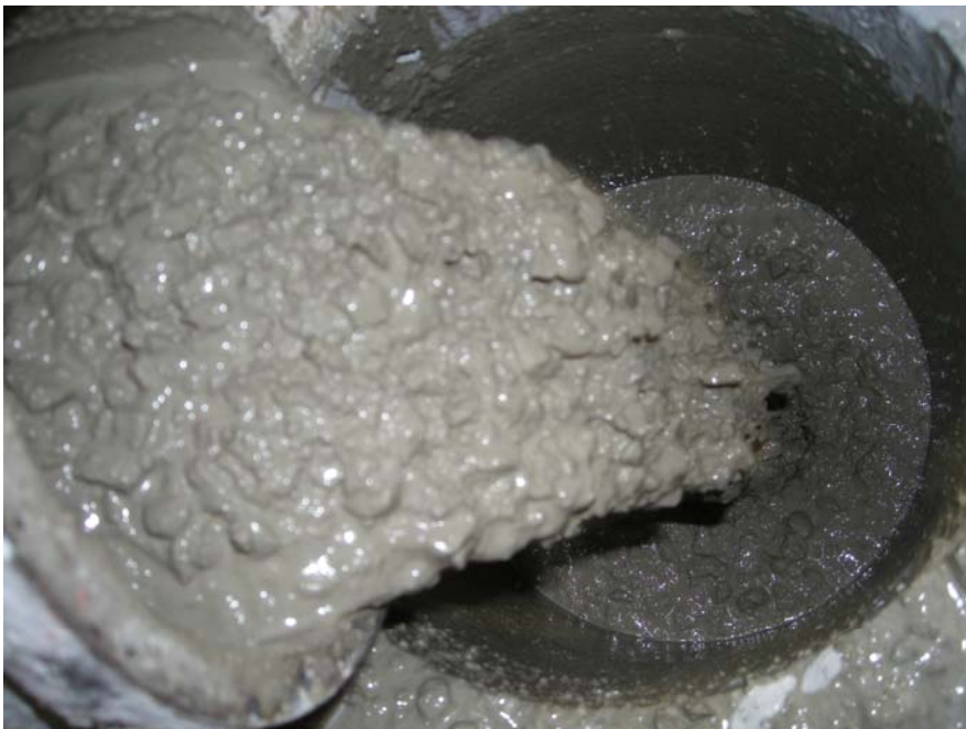
Hormigonado bajo la losa con Hormigón autocompactante.
