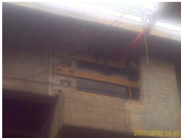
Preparación del punto de hormigonado.
