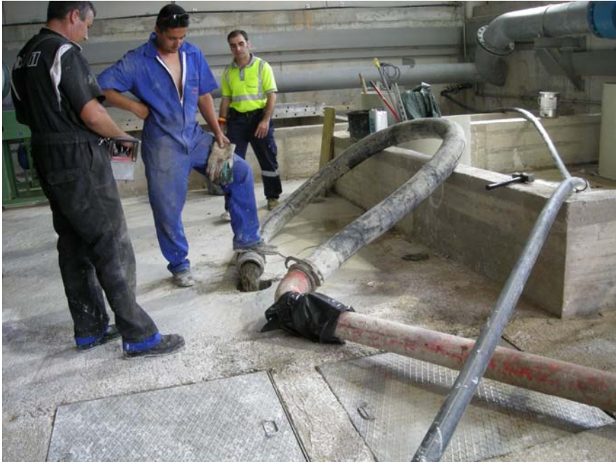
Hormigonado mediante bombeo con gran longitud de tubería.
