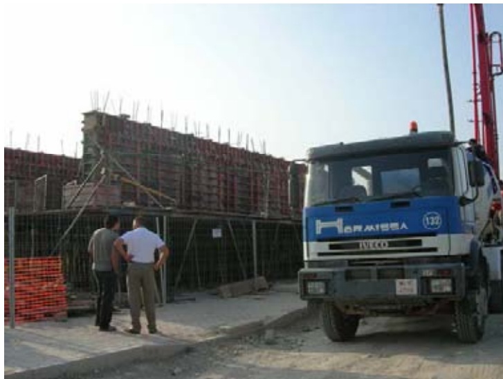
Hormigonado de la pieza
