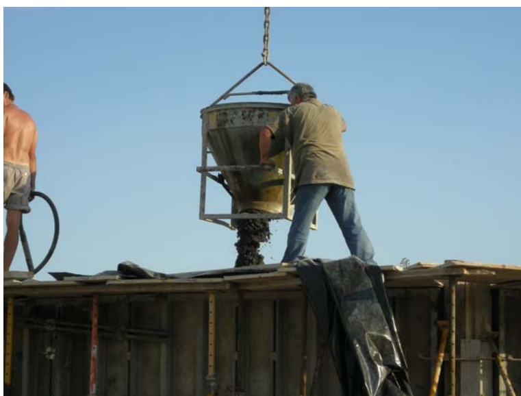
Ejecución del Muro
